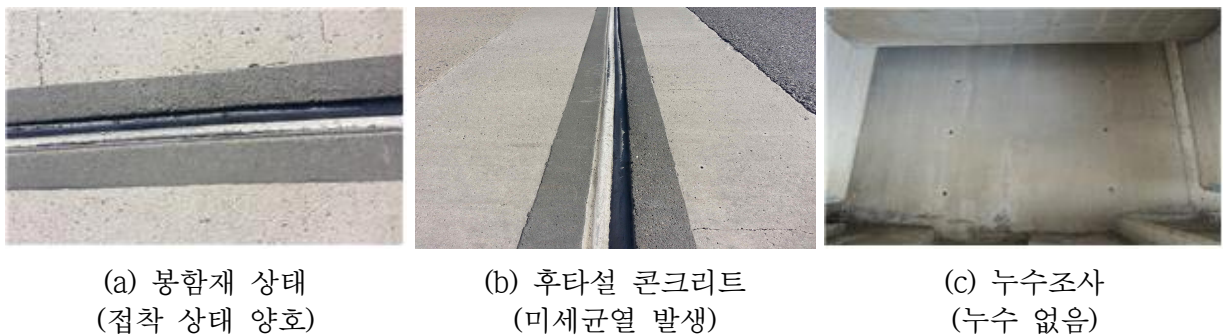
그림 5.11 탄성콘크리트(컴프레션셀) 시공후 조사
