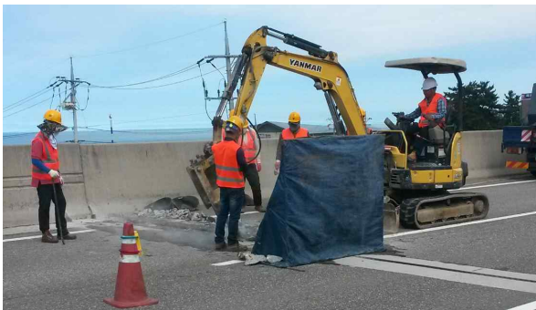
(a) 콘크리트 깨기
