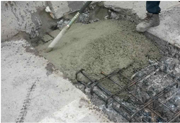
(e) 초속경 콘크리트 타설
