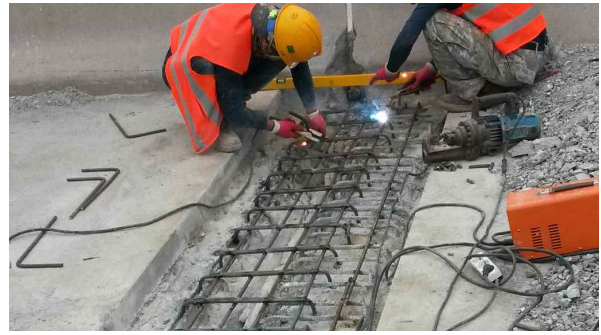
(d) 연결철근 설치
